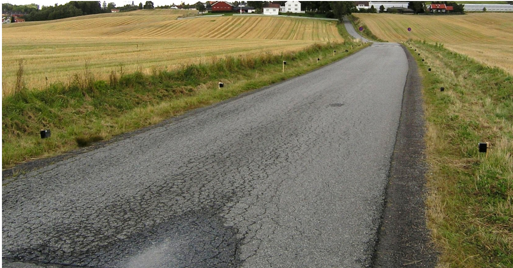
Figur 3.2 Akseovervåking av en 190m lang veiakse fra [33]. 40 sensornoder med radar, IR og akustisk sensor utplassert.
