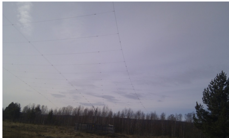
Figur 3.1 Horisontal log-periodisk antenne på Helgelandsmoen. Retning 285°W.
