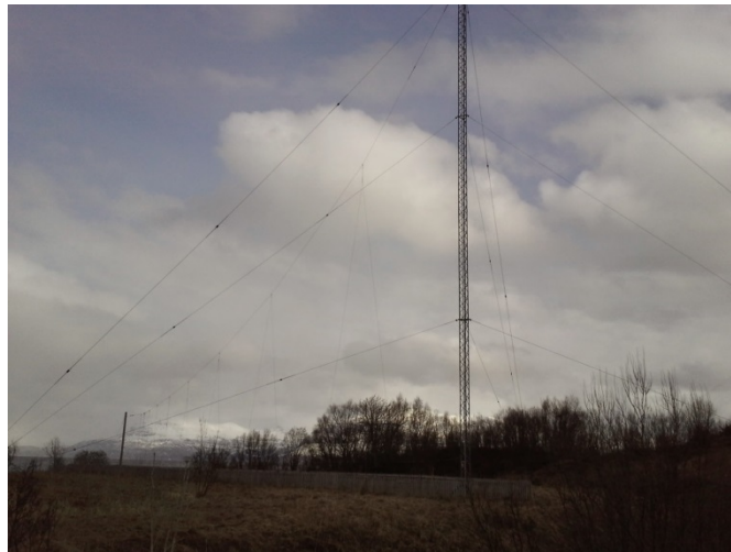
Figur 3.3 Vertikal log-periodisk antenne på Stangnes. Retning 60°E.
