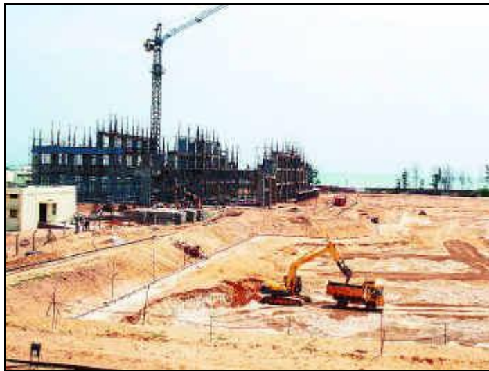
Figur 3-4 Bygging av formeringsreaktoren PFBR er i gang per 2004. Hentet fra DAE (42).
