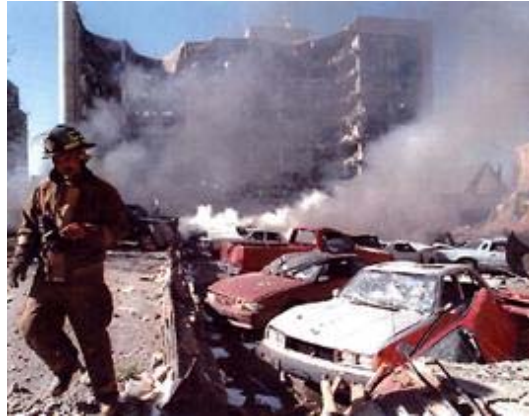
Figur 1.1 Bilbomben som gikk av på en parkeringsplass foran den føderale Alfred P. Murrah-bygningen i Oklahoma City, USA i 1995, tok livet av 168 1 mennesker.
