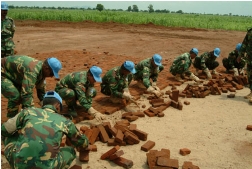
Figur 3.9 UNMIS bygger veier i Juba, Sudan (Kilde: www.un.org )
