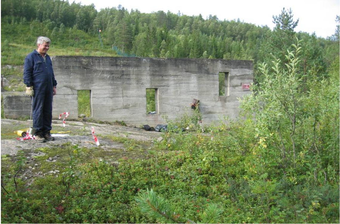
Figur 4.17 Standplass på panservernbane som viser murveggen med skytevinduer. Bildet er tatt i skyteretningen.
