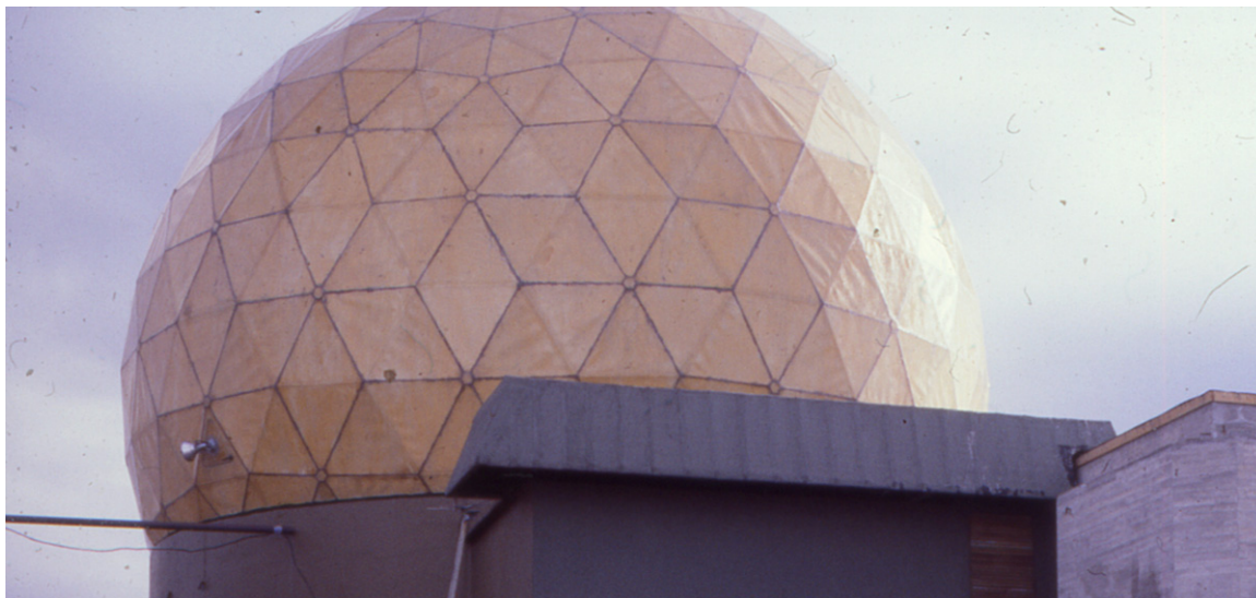
Figur 2.1 Bilde av radomen etter lakkering på 1970-tallet.
