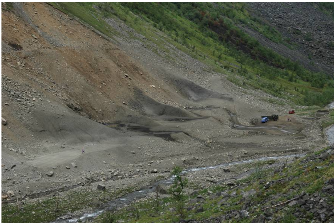
Figur 1.1 Demoleringsområdet i Øyradalen.
