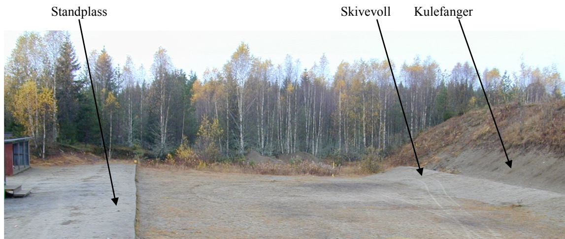
Figur 3.1 Basisskytebane med standplass, skivevoll, og kulefanger i Sessvollmoen skyte- og øvingsfelt. Foto: FFI
