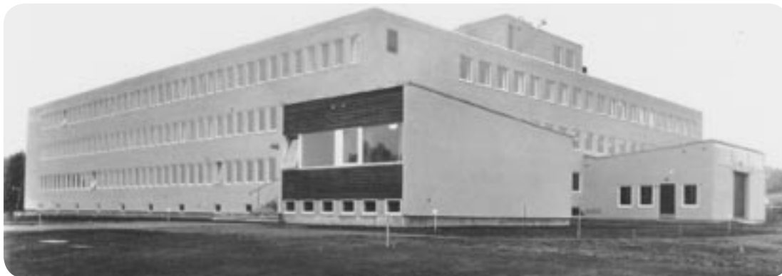
Elektronikkbyggets første byggetrinn på 4000 m 2 1962.
