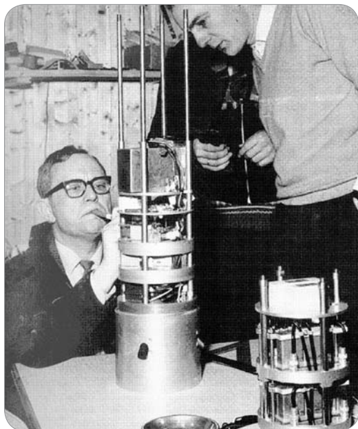
Integrering av den første nyttelasten. Odd Dahl til venstre og Arne Ryen under den endelige monteringen av instrumentlasten som skal skytes opp med Ferdinand 1.
