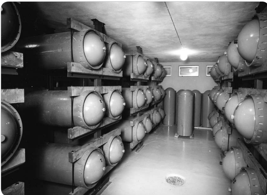
48 torpedotrykkflasker i nedgravd bunker bak vindtunnelen.
