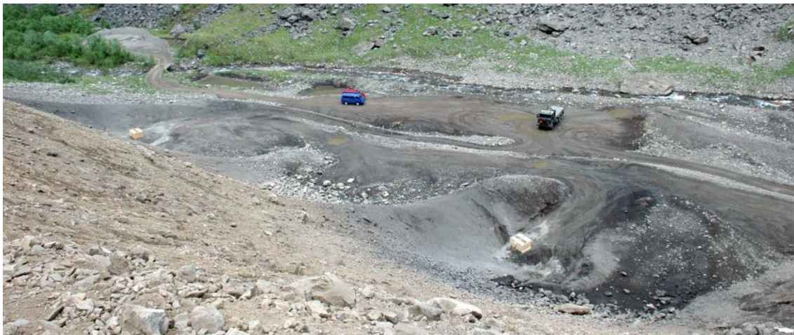
Figur 1.2 Demoleringsgropene på destruksjonsanlegget i Øyradalen.
