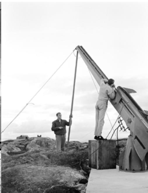
Dette bildet fra 1963 viser den aller første Penguin-raketten, Enok, på utskyttingsrampen. Den aerodynamiske utformingen var testet i vindtunnel, men nå var det alvor.
