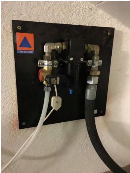
Illustrasjon: Eksempel på varslingsanlegg (Foto: T. Grunnan).
