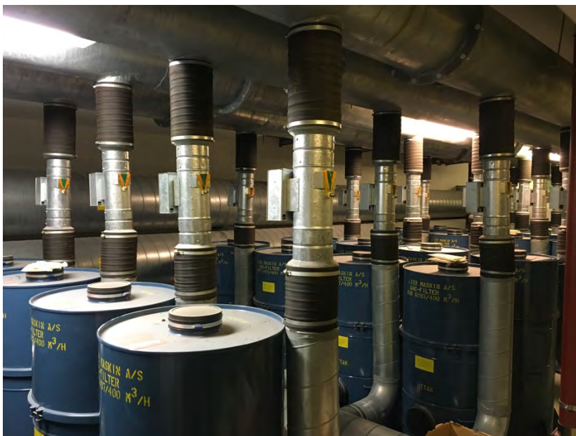
Illustrasjon Eksempel på ABC-filtre i tilfluktsrom (Foto: T. Grunnan).
